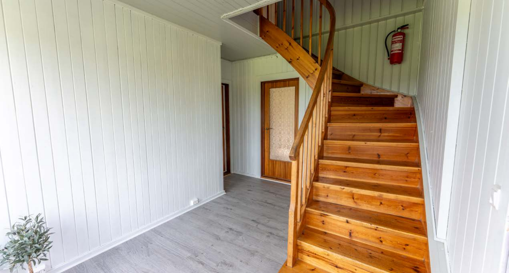
Fra entréen går trappeløpet som binder etasjene sammen.
