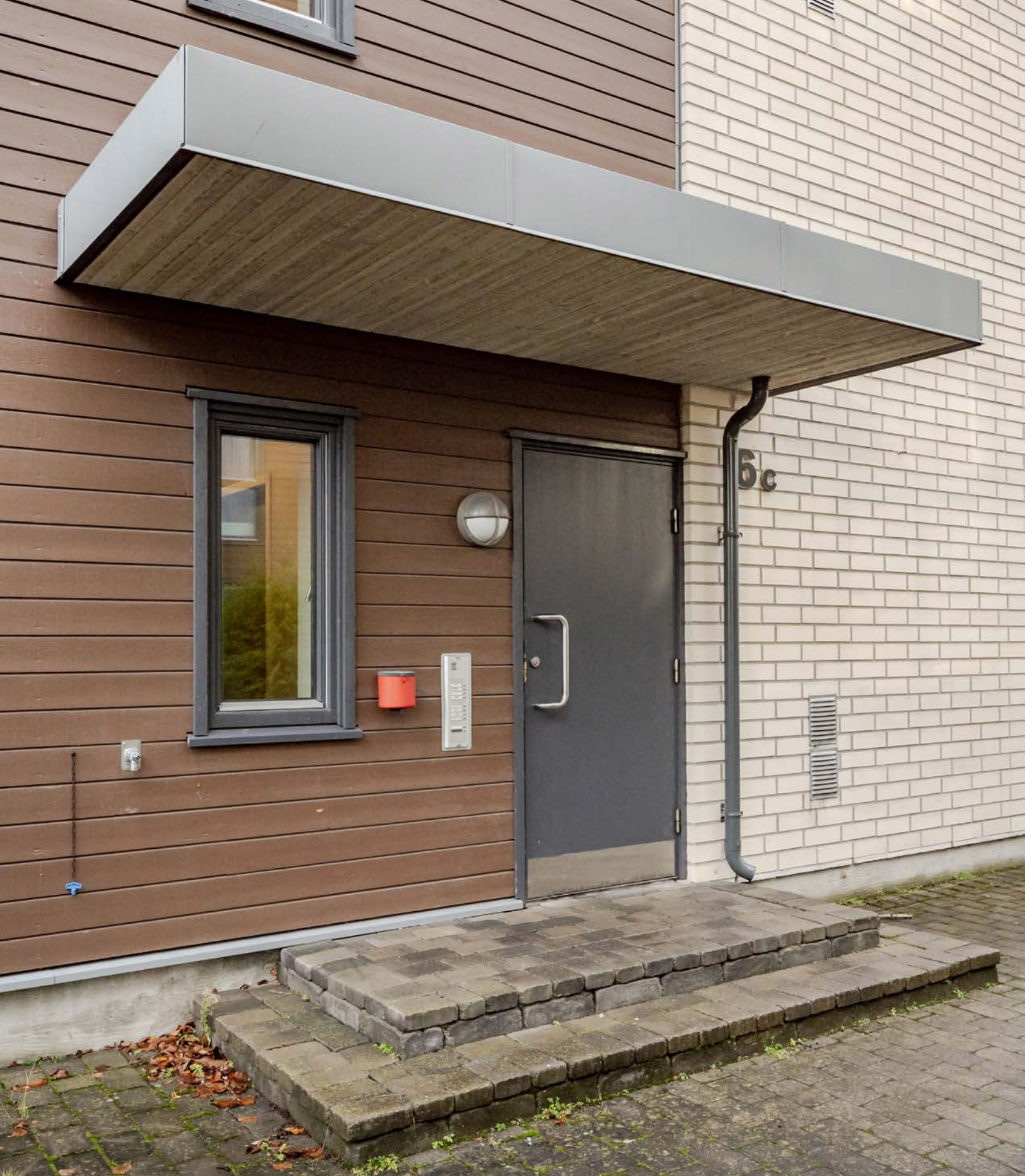
Overbygget inngangsparti med calling-anlegg.
