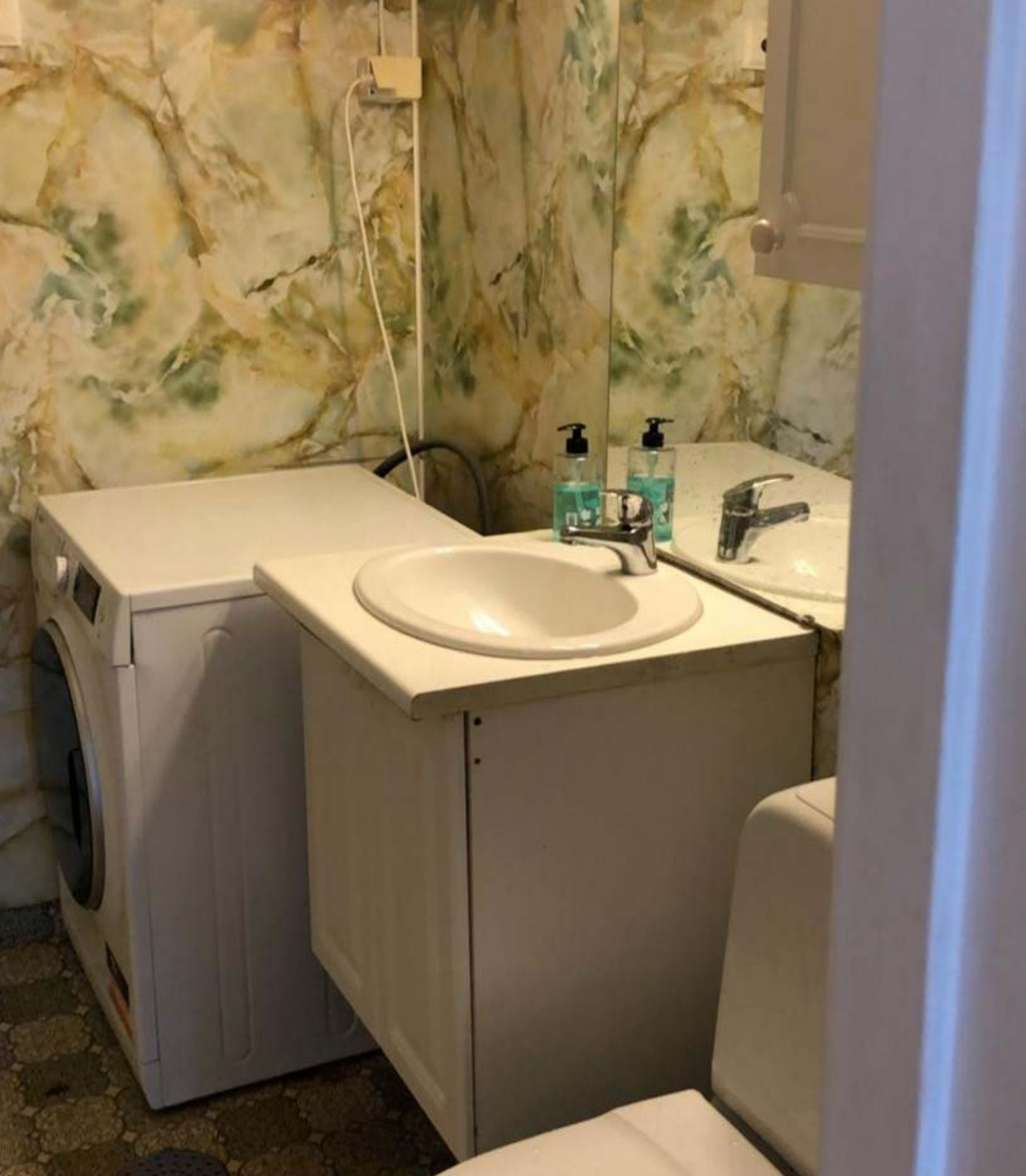
Bad/vaskerom utleiedel med dusjkabinett og opplegg for vaskemaskin.
