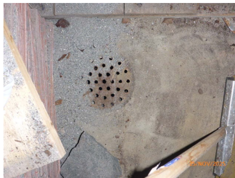
Soilsluk i utv. bod, slukrist står fast.
