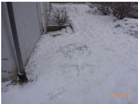
Ikke fall fra bygget i øst.
