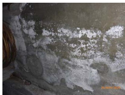
Mot nordvest opprinnelig bygg under vf.
