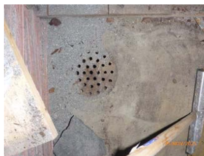
Soilsluk i utv. bod, slukrist står fast.
