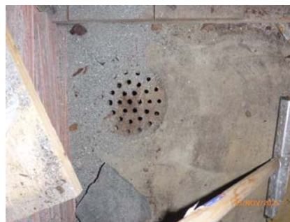
Soilsluk i utv. bod, slukrist står fast.
