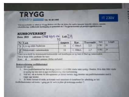
Kursoversikt i sikringsskap
