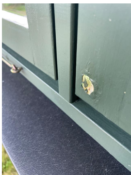
Værslittasje/oppsprukket overflatebehandling.
