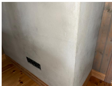
Sprekk i brannmur mot soverom
