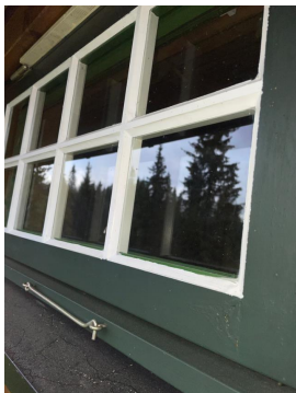
Værslittasje/oppsprukket overflatebehandling.
