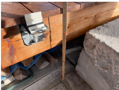
Trapp mellom terrasser
