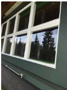
Værslittasje/oppsprukket overflatebehandling.
