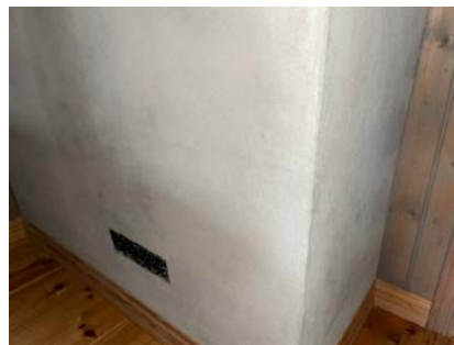
Sprekk i brannmur mot soverom
