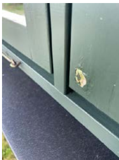
Værslittasje/oppsprukket overflatebehandling.
