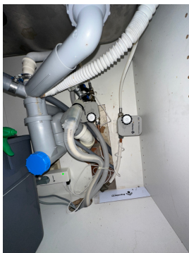
Røropplegg i kjøkkenbenk med Waterguard
