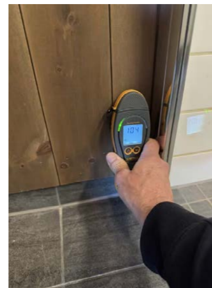
Paneler i våtsone men ingen påvist fukt.
