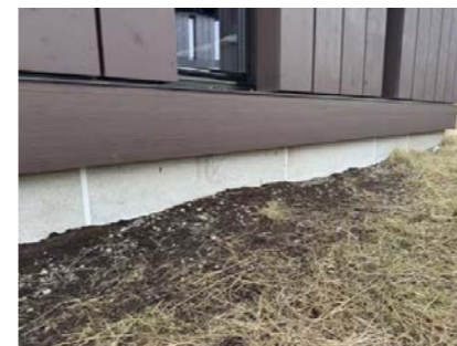
Ringmurselementer etablert på drenerende masser.
