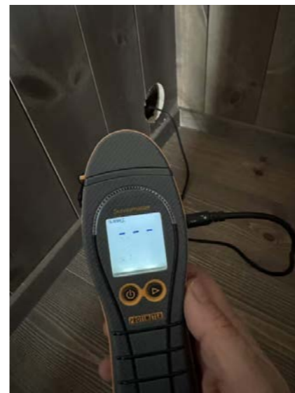
Ingen påvist fukt ved måling inne i vegg mot dusjsone.
