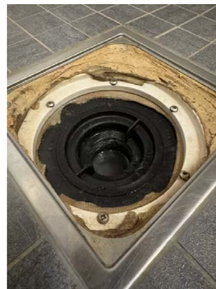
Plastsluk med synlig membran.
