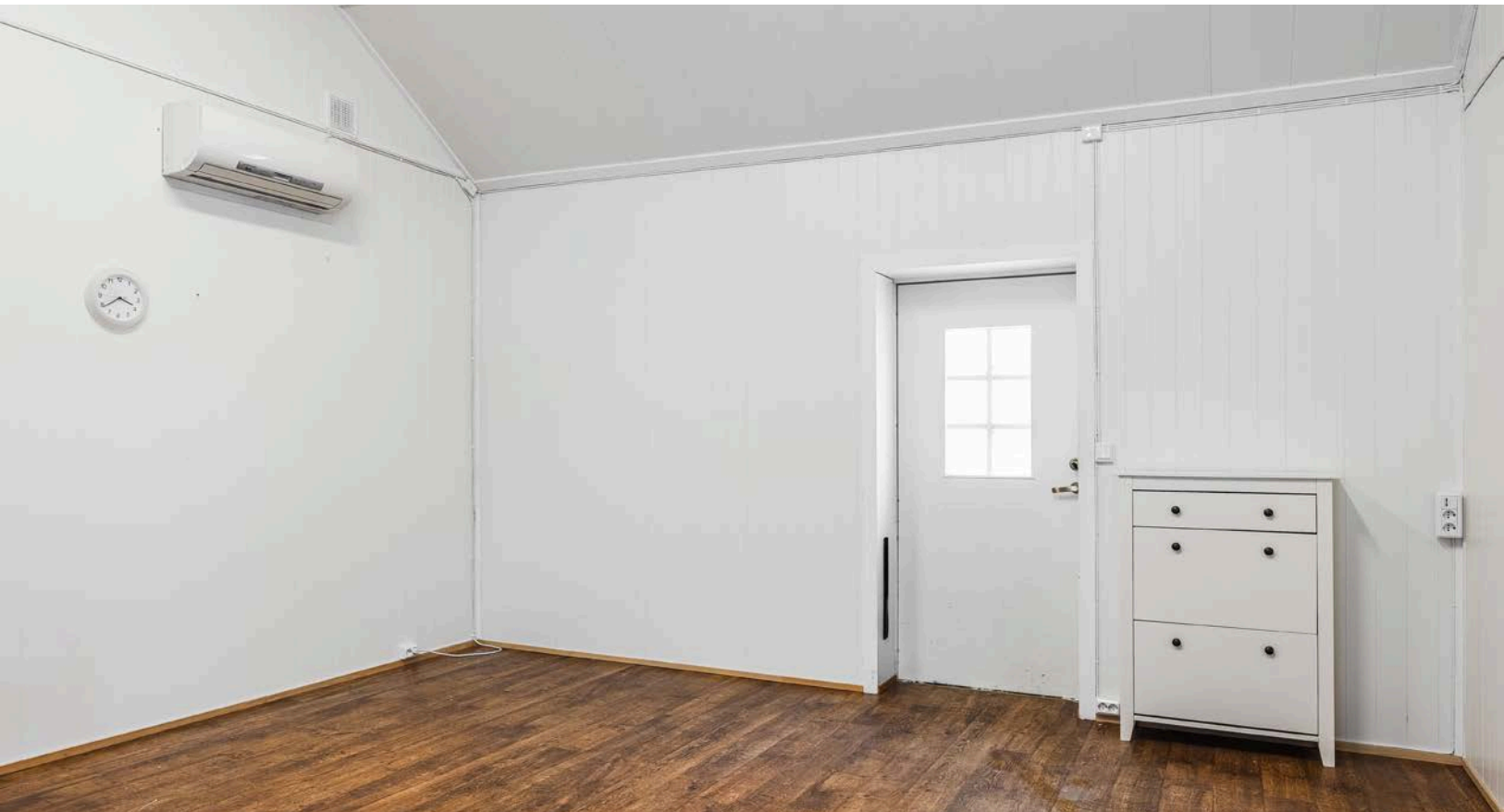
Uthus/anneks varmes opp med luft-luft varmepumpe fra 2009. Det er også innlagt vann og avløp.
