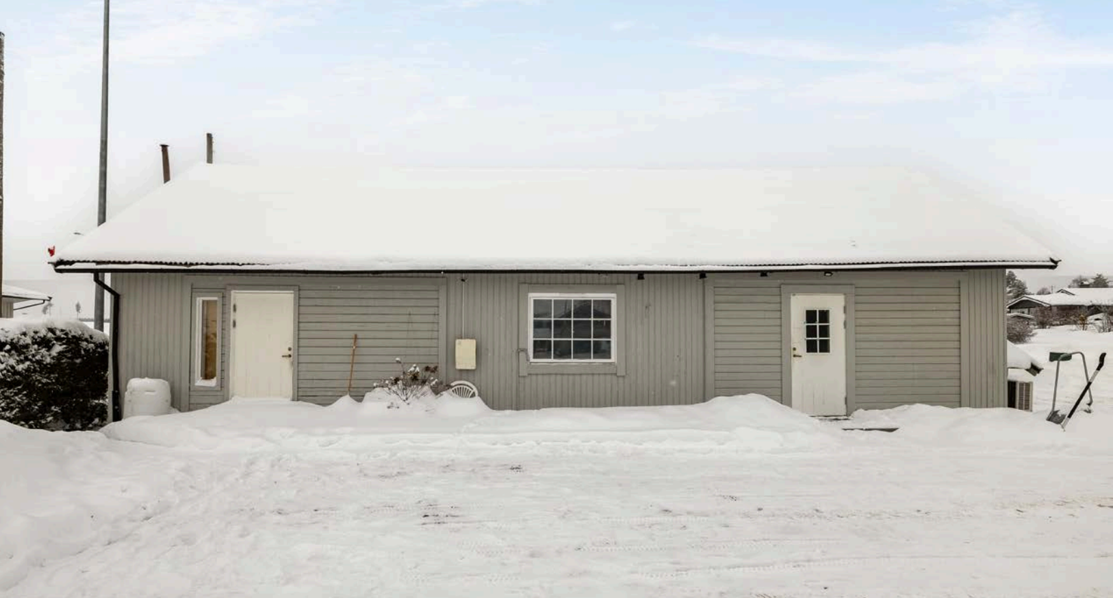
Tidligere uthus på 80m 2 som er isolert og innredet med nye gulvflater og overflater i 2021.
