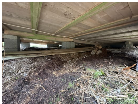
Viser del av krypkjeller.
