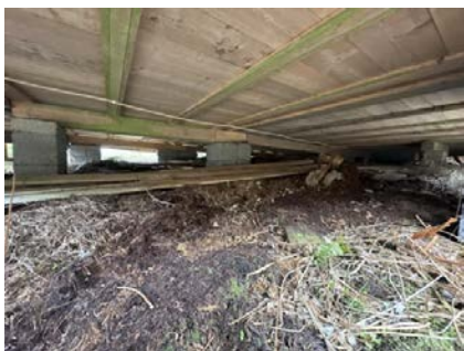
Viser del av krypkjeller.
