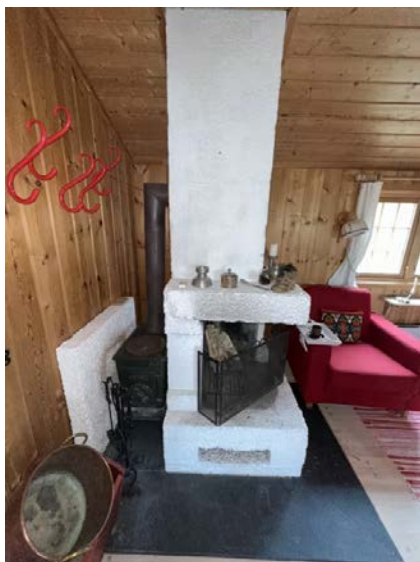
Viser ildsted montert i stue
