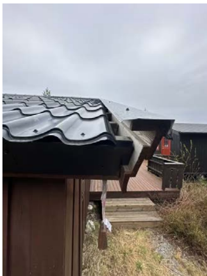
Åpning med behov for tilpassing/justering.
