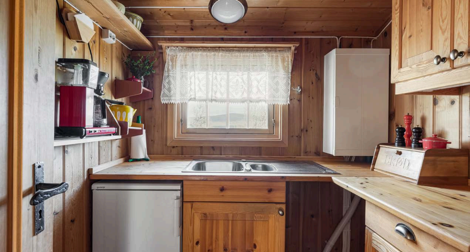
Heltre kjøkkeninnredning med profilerte fronter. Metallkum med benkebeslag, avrenningsfelt og med avløp ført til terreng.
