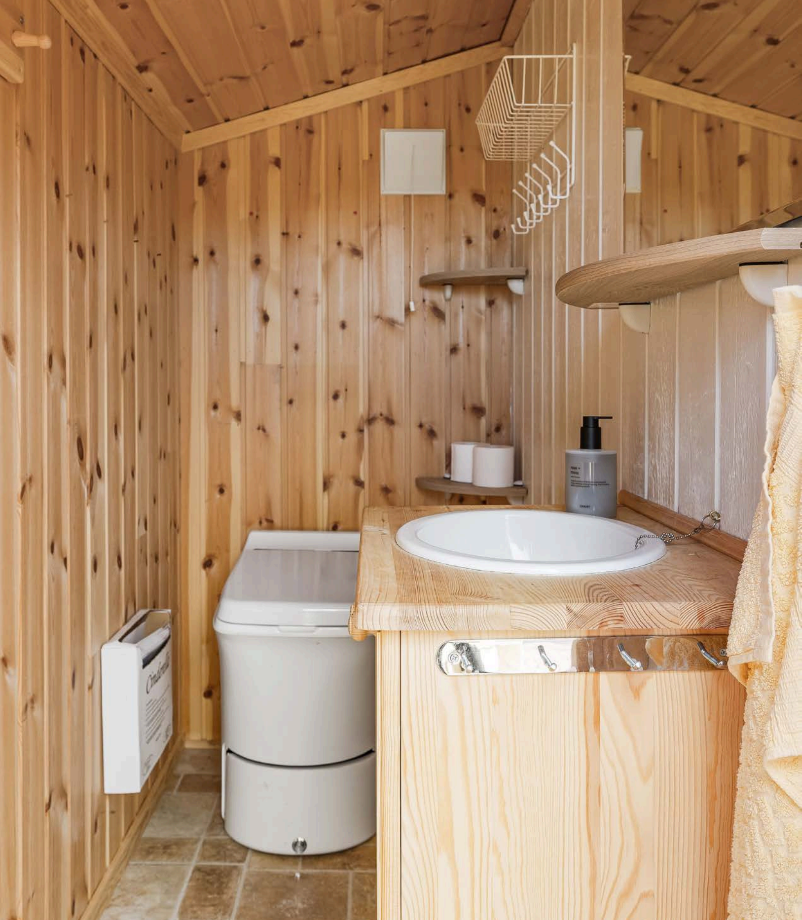
Annekset har inntilbygget toalettrom med utvendig adkomst. Rommet har Cinderella forbrenningstoalett og innredning med nedfelt vask med avløp til terreng.
