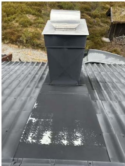
Viser pipebeslag over tak.
