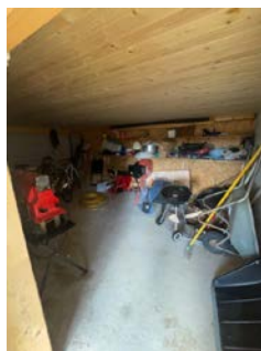
Kjeller og kryperom under tilbygg
