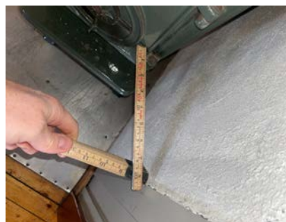
Avvik til brennbar ved ilegg under 30 cm
