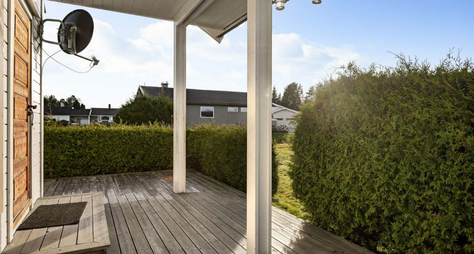
Terrassen som ble bygget i ca. 2005 er delvis overbygget og har terrassebord på gulv.
