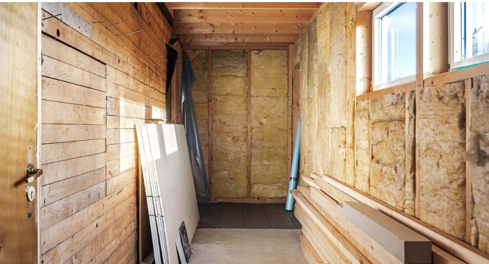
Tilbygget lagerrom med noe gjenstående arbeider.
