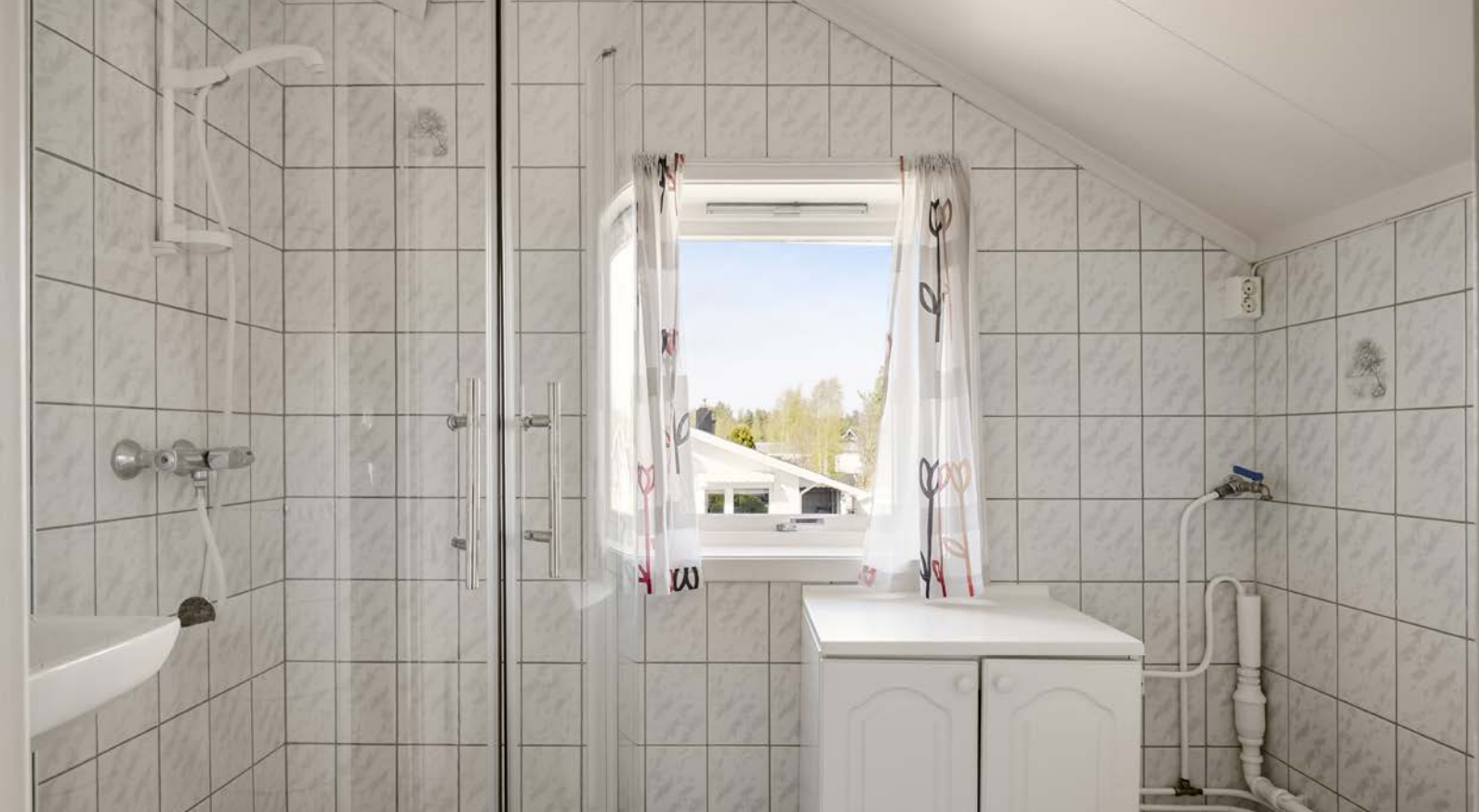
Bad/vaskerom i 2. etasje med våtromsbelegg på gulv og fliser på veggene.
