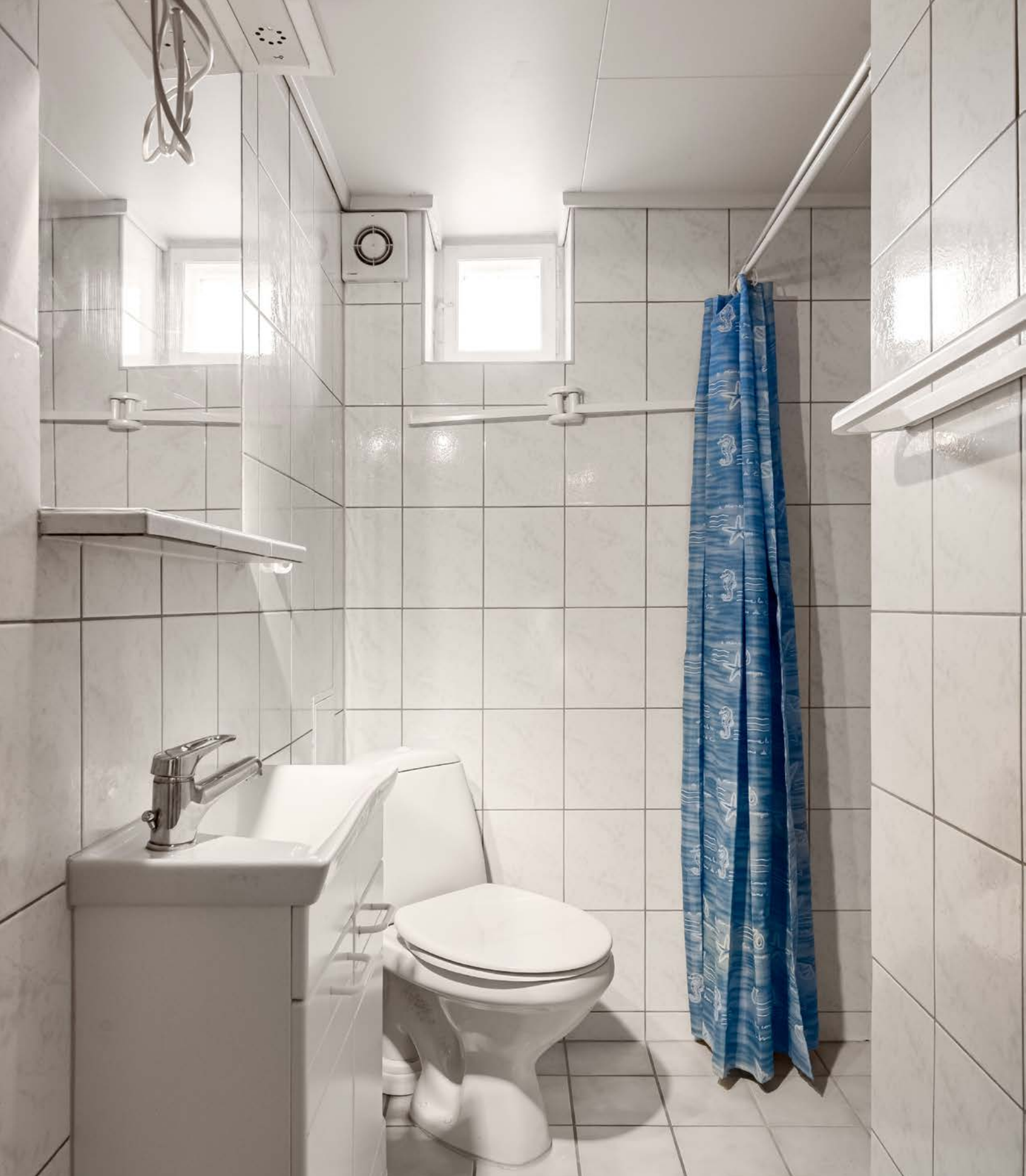
Baderom i kjeller med overflater, installasjoner og komponenter fra ca. 2005. Baderommet har fliser på gulv og vegger, gulvvarme og elektrisk styrt vifte.
