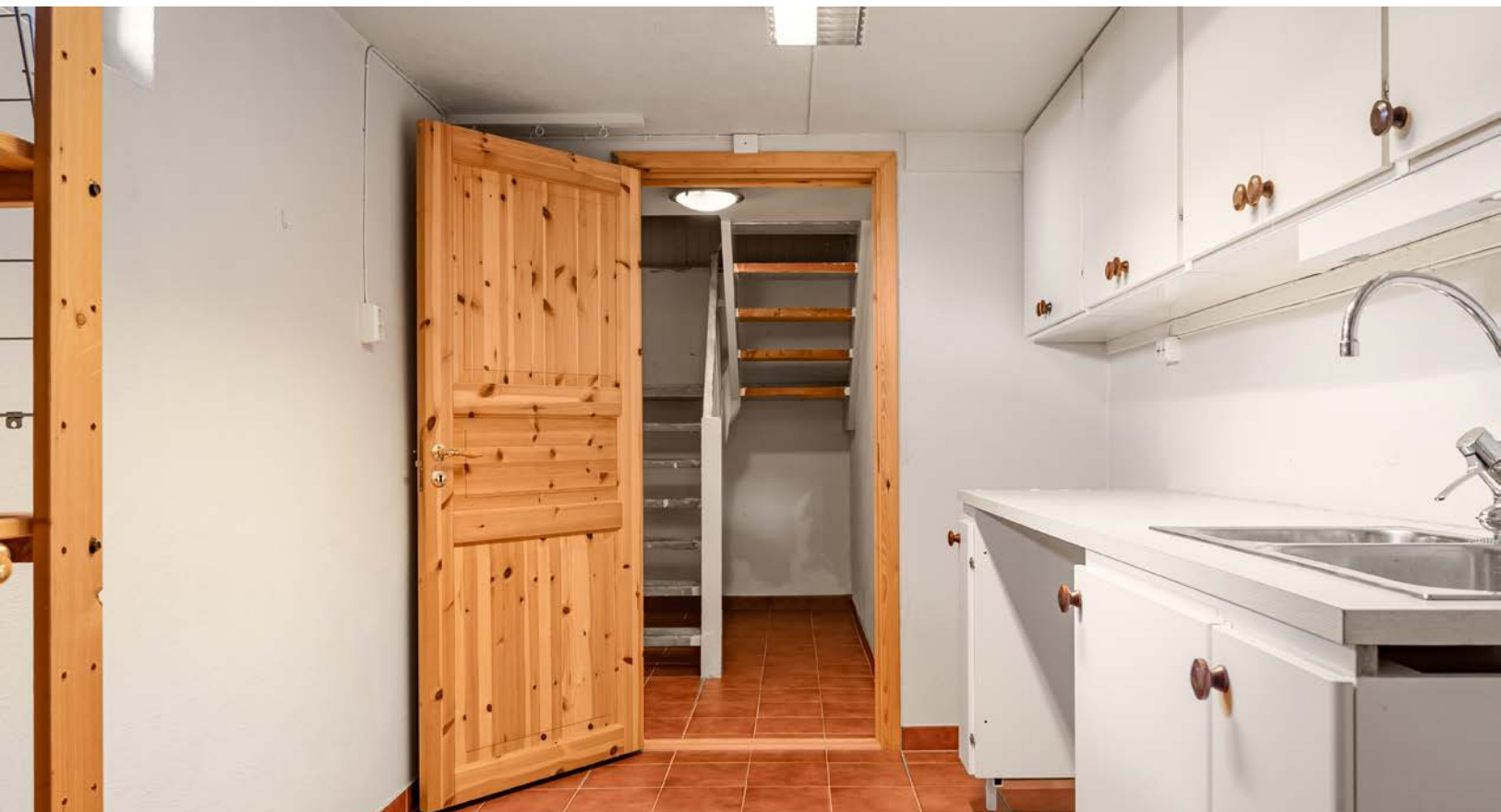
Eldre innredning i kjeller med lyse fronter og laminert benkeplate med nedfelt oppvaskkum.
