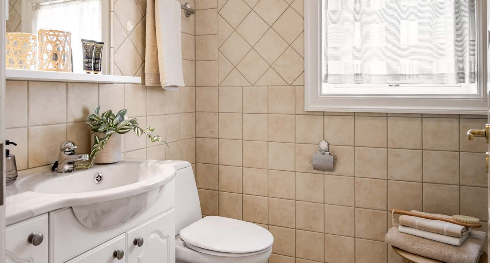
Baderom i 1. etasje med overflater, installasjoner og komponenter fra ca. 2005. Baderommet har fliser på gulv og vegger, gulvvarme og elektrisk styrt vifte.
