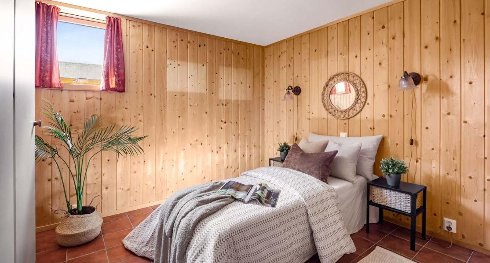
Rom benyttet som soverom i kjeller. Det gjøres oppmerksom på at soverom i kjeller har ikke godkjente rømningsvinduer.
