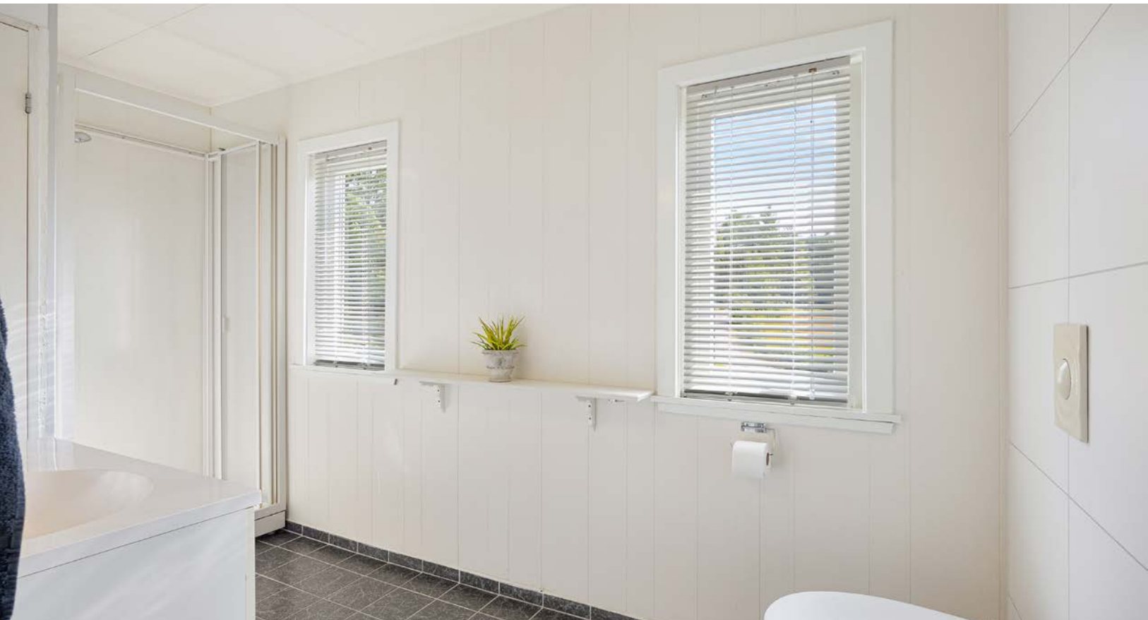
Gulvet har vannbåren varme og fliser, mens veggene har en kombinasjon av flisimiterte plater og hvitmalte panelplater. Det er for øvrig toalett, dusjkabinett og opplegg for vaskemaskin.
