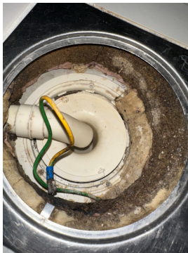
Plastsluk med klemring for membran
