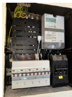
Sikringskap med automatsikringer.
