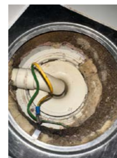
Plastsluk med klemring for membran
