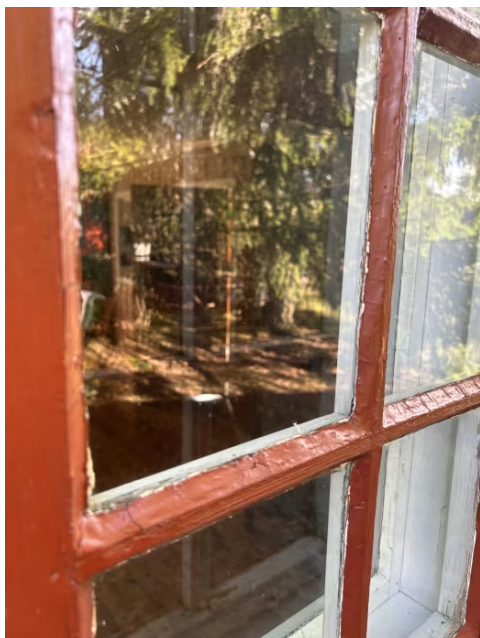
Værslitt og sprukne kittfalsler.
