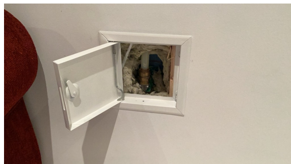
Inspeksjonsluke i stue.
