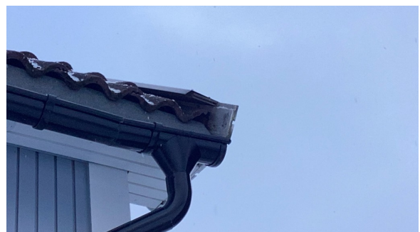
Isbord er avsluttet tidlig, dekker ikke hele vindski
