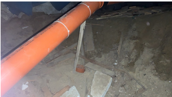
Noe enkel innfesting av avløpsrør med klosser under bjelkelag.
