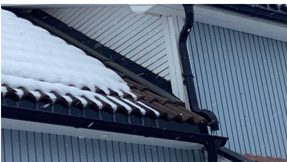
Beslag er lagt utenpå kledning på begge sider av takløft.
