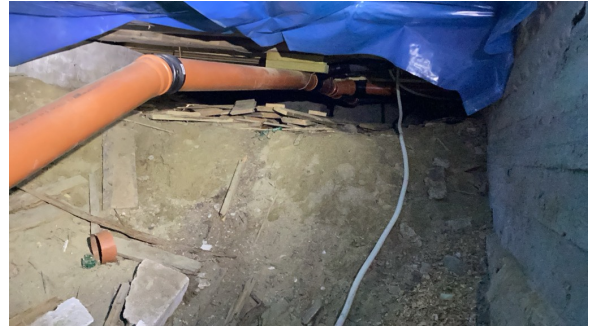
Oversikt over kryperom. Deler av arealet er ikke tilgjengelig for inspeksjon.
