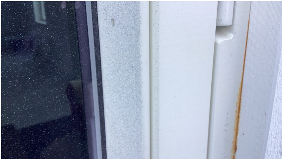
Søl fra malingssprøyte på karm og glass.
