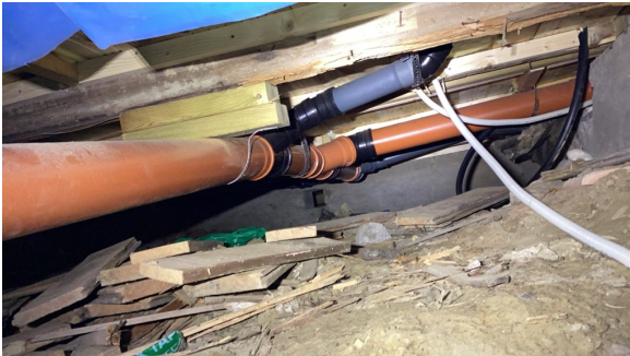
Noe enkel innfesting av avløpsrør med klosser under bjelkelag.
