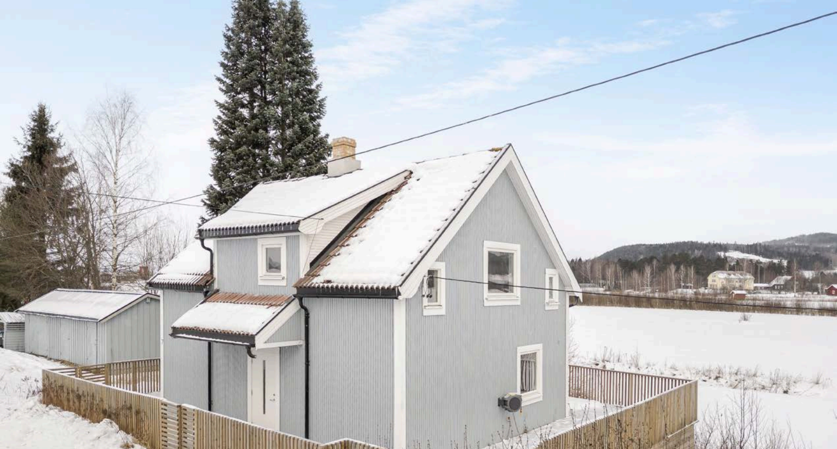
Huset har kledning, tak og inngangsdør fra 2023.
