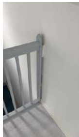
Innfesting med klosser mellom vegg og stolpe.
