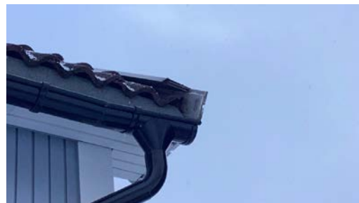
Isbord er avsluttet tidlig, dekker ikke hele vindski
