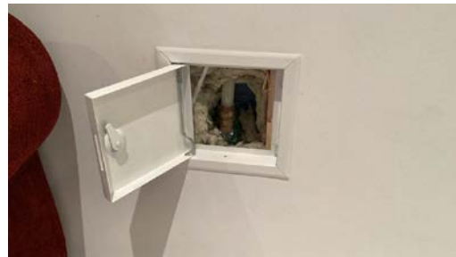
Inspeksjonsluke i stue.
