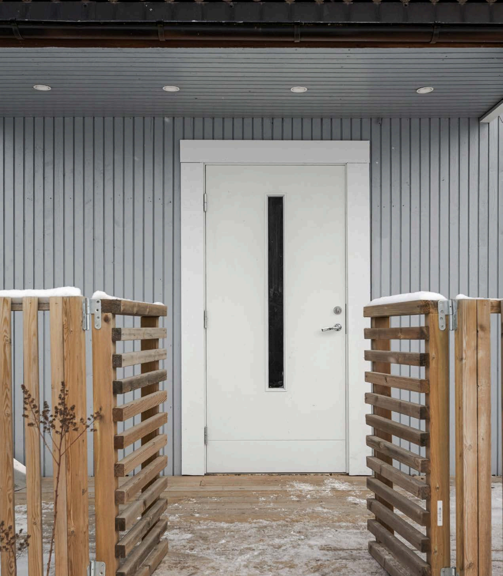
Inngangspartiet har takoverbygg og det er port med mulighet for å kunne stenge av ut mot veien.
