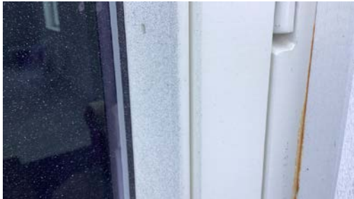
Søl fra malingssprøyte på karm og glass.
