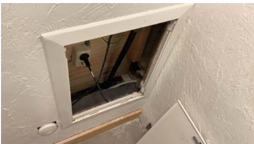
Inspeksjonsluke på bodrom.
