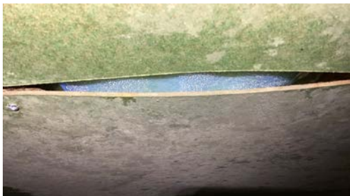
Plater i himling buler og det er kondens på oversiden av dampspærre flere steder.
