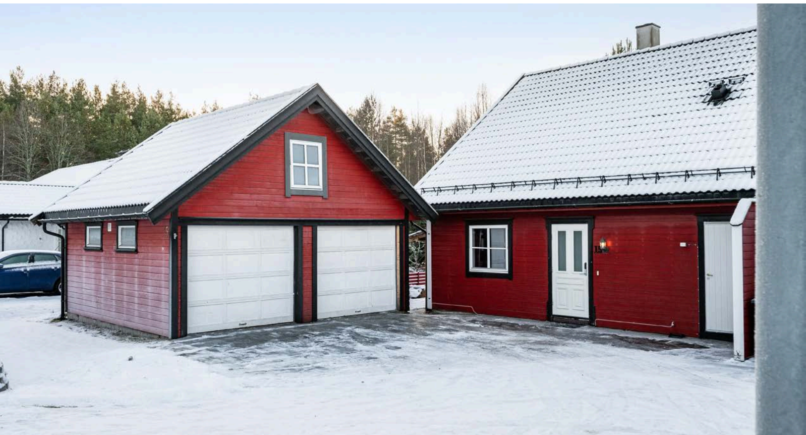
Eiendommen er også bebygd med en dobbelgarasje fra 2007, med portåpner montert i 2023. Fast dekke/belegningsstein på gårdsplassen.
