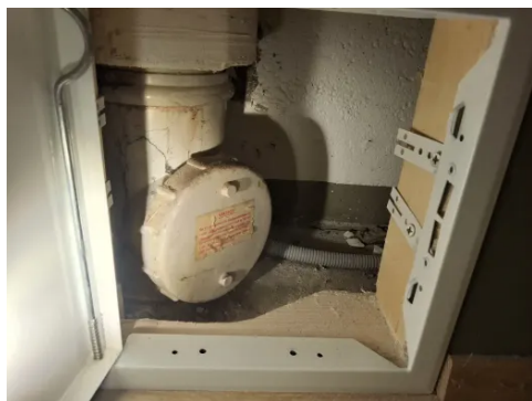
Stakeluke og avløpsrør fra byggeår.
