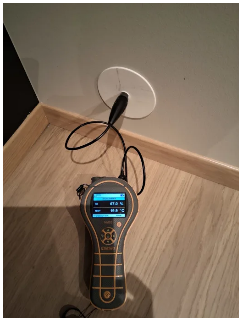
Bilde fra fuktmåling i utlektet veggkonstruksjon.
