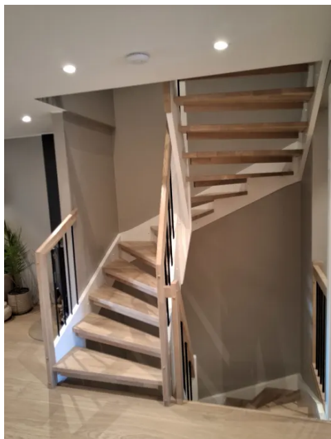
Åpen tretrapp mellom etasjene.
