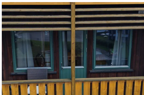
Vinduer og balkongdør med karm av tre og to-lags glass.
