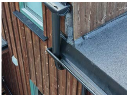
Boligen har takrenner og nedløpsrør i metall.
