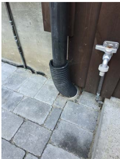
Taknedløp er ledet til lukket rør.
