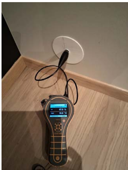
Bilde fra fuktmåling i utlektet veggkonstruksjon.
