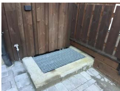
Grunnmuren er ikke tilgjengelig for undersøkelser.
