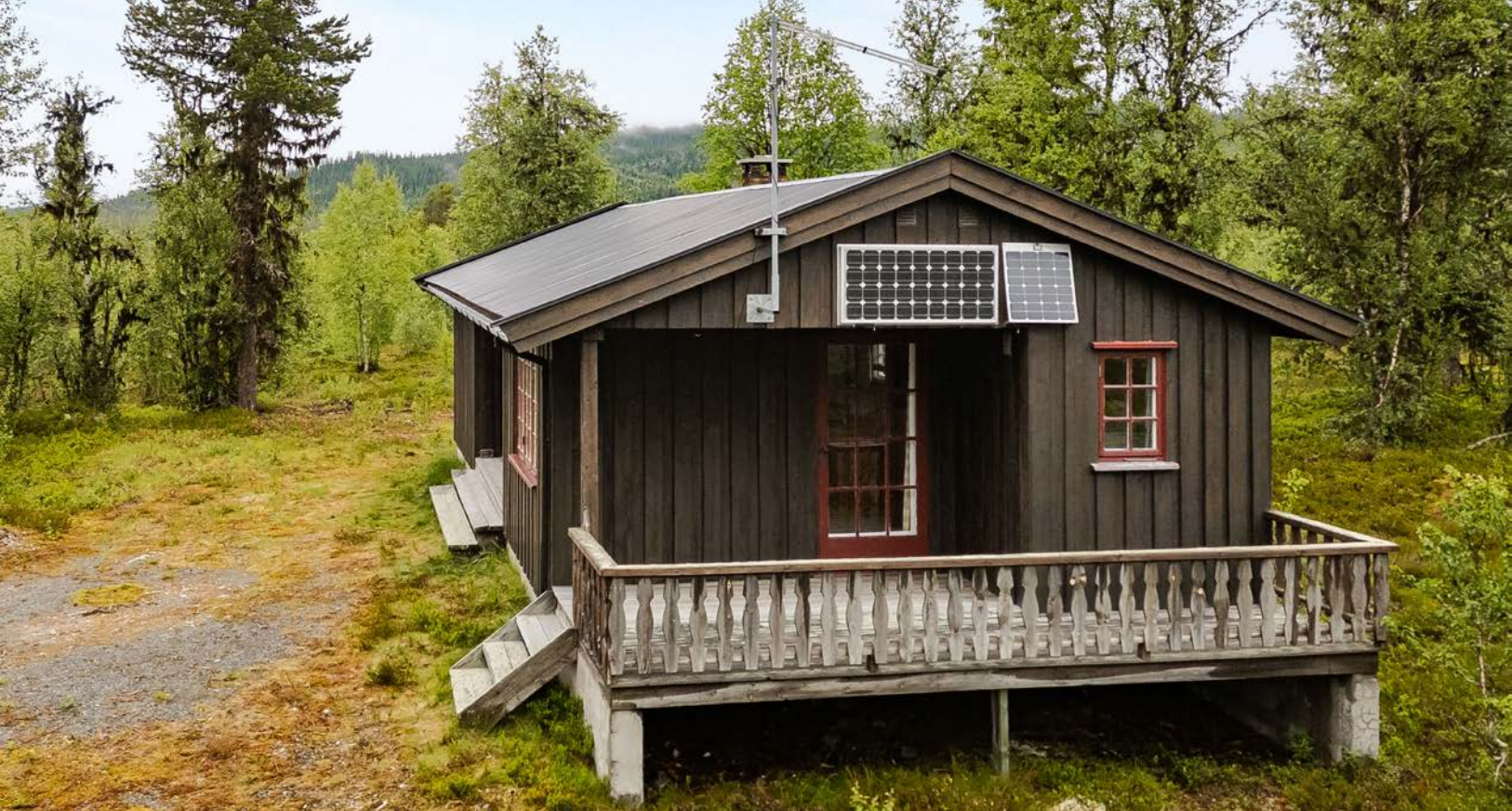
Det er montert 12 volts solcellepanel for belysning.
