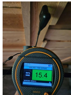
Måling av trefukt i krypkjeller under tilbygg.
