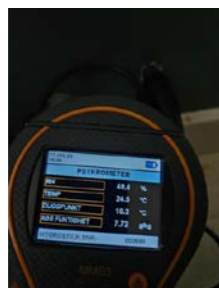
Måling relativ luftfuktighet i lukket veggkonstruksjon fra soverom mot dusjsone.
