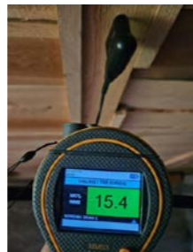
Måling av trefukt i krypkjeller under tilbygg.
