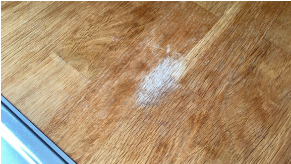
Misfarget flekk på benkeplate.
