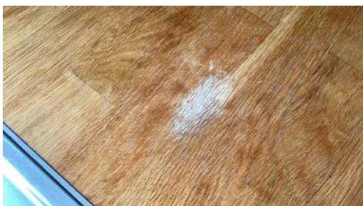
Misfarget flekk på benkeplate.
