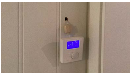
Ufagmessig utførelse på innfesting av bryterpanel.
