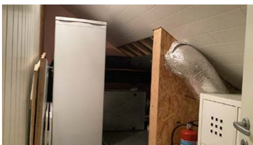
Gjenstående arbeid på bod/teknisk rom.
