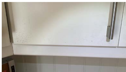
Malingflass og riper på enkelte skapdører.
