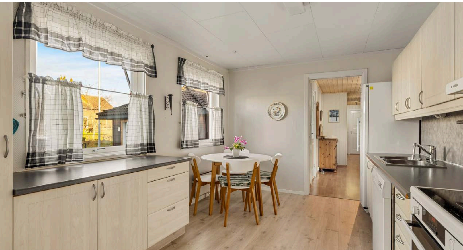
Kjøkkeninnredning med skrog fra 1980, profilerte fronter fra ca. 1996 og laminert benkeplate fra 1998 med nedfelt oppvaskkum.
