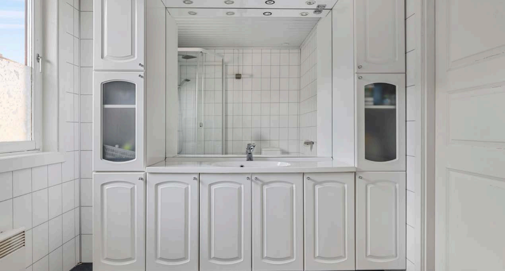
Boligen har et lyst baderom med våtromsbelegg fra 1995/96 på gulv, lyse våtromsplater fra 2013 på veggene og mekanisk avtrekksvifte.
