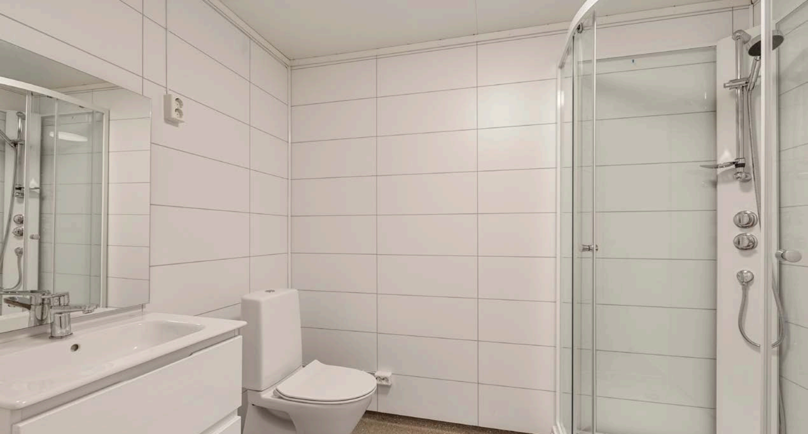
Nytt og ubrukt baderom tilknyttet hybeldelen. Badet rommet har våtromsbelegg på gulv og lyse våtromsplater på veggene. Hybeldelen har også et teknisk rom med opplegg for vaskemaskin.
