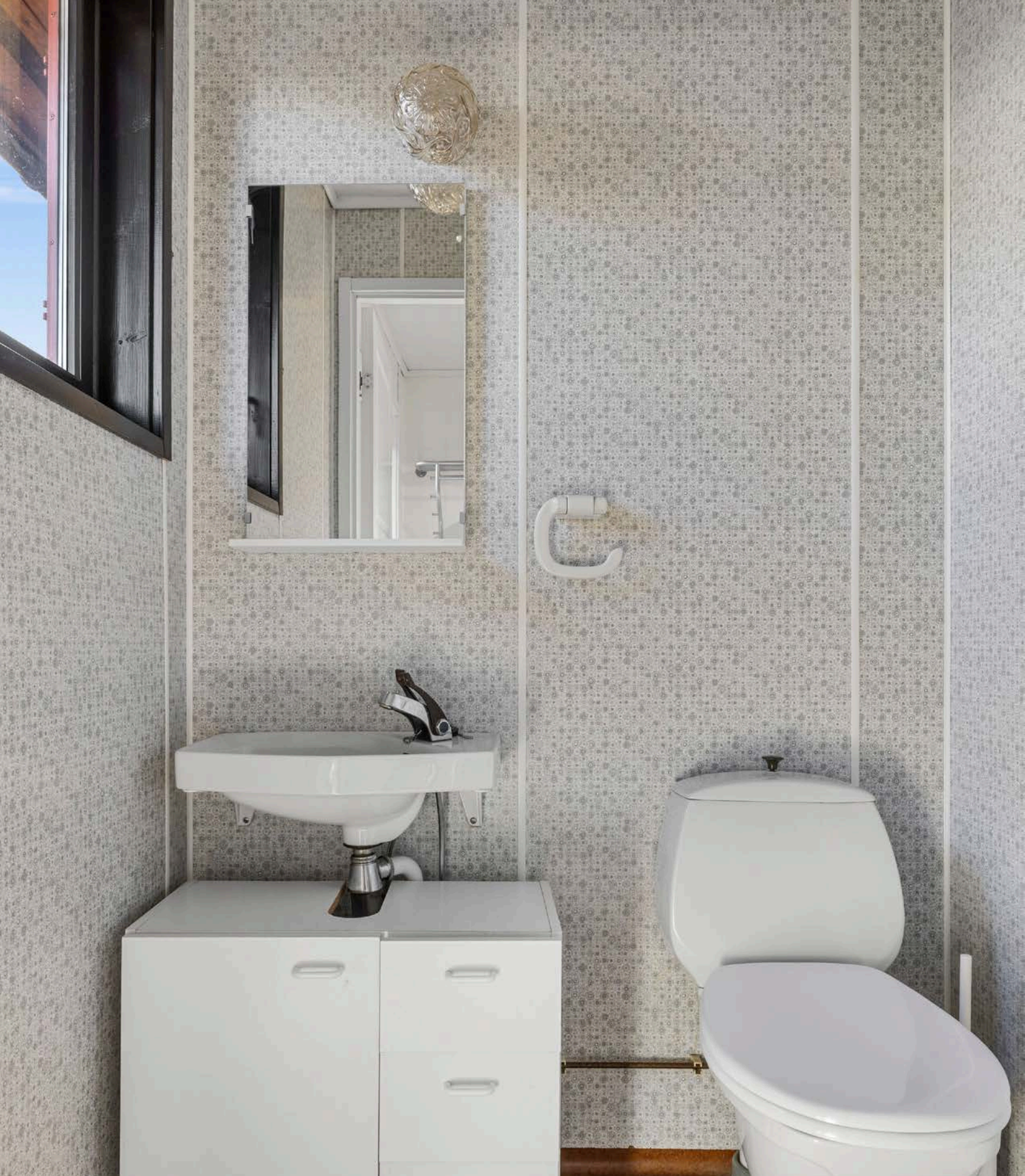
Fra entréen er det adgang til et praktisk ekstra toalettrom med belegg på gulv og våtromsplater på veggene.
