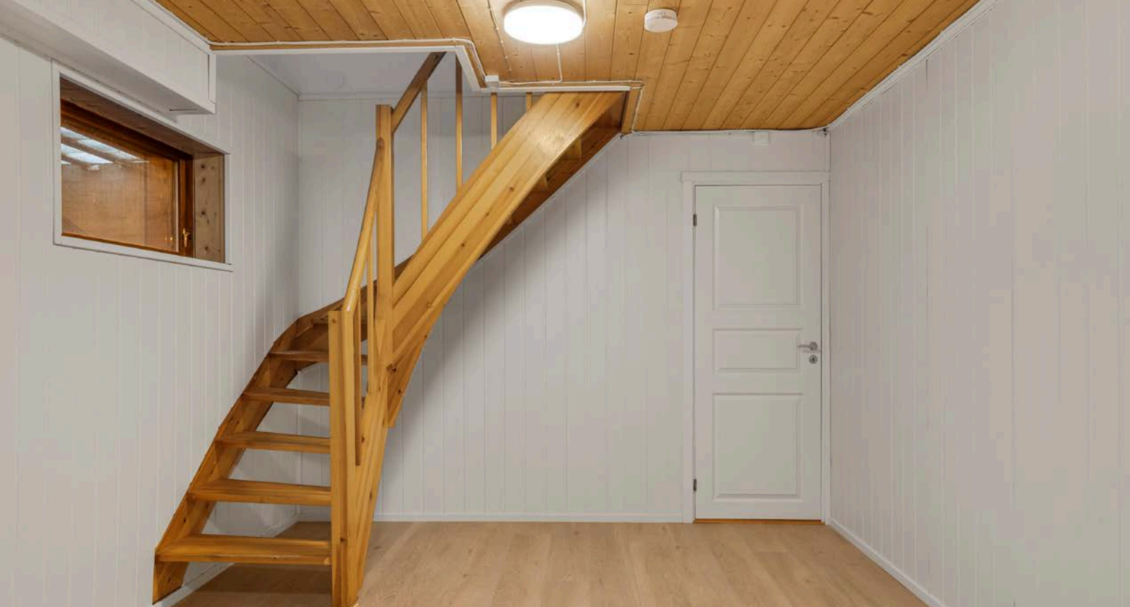
Gang/trapperom i kjeller som ble oppgradert i 2022/24 med nytt enstavs gulv med varmemefolie under og lyse panelplater på veggene.
