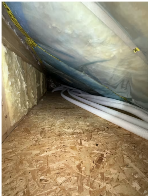
Viser raftekott med adkomst via luke.
