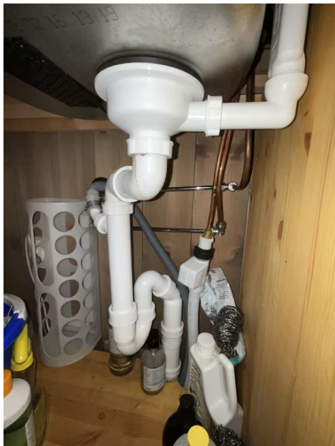
Viser vann og avløpsinstallasjoner under kum.
