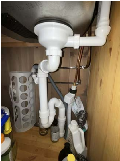
Viser vann og avløpsinstallasjoner under kum.
