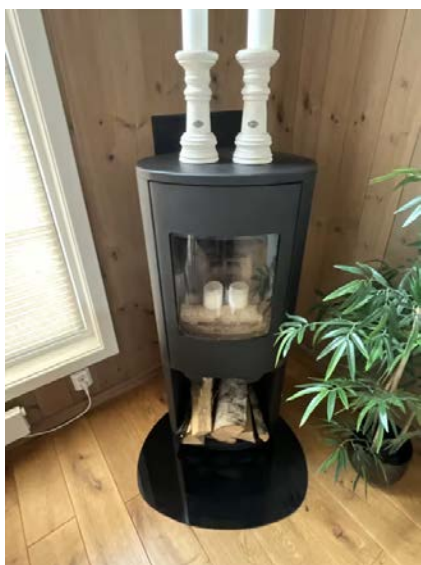
Viser ildsted montert i stue.
