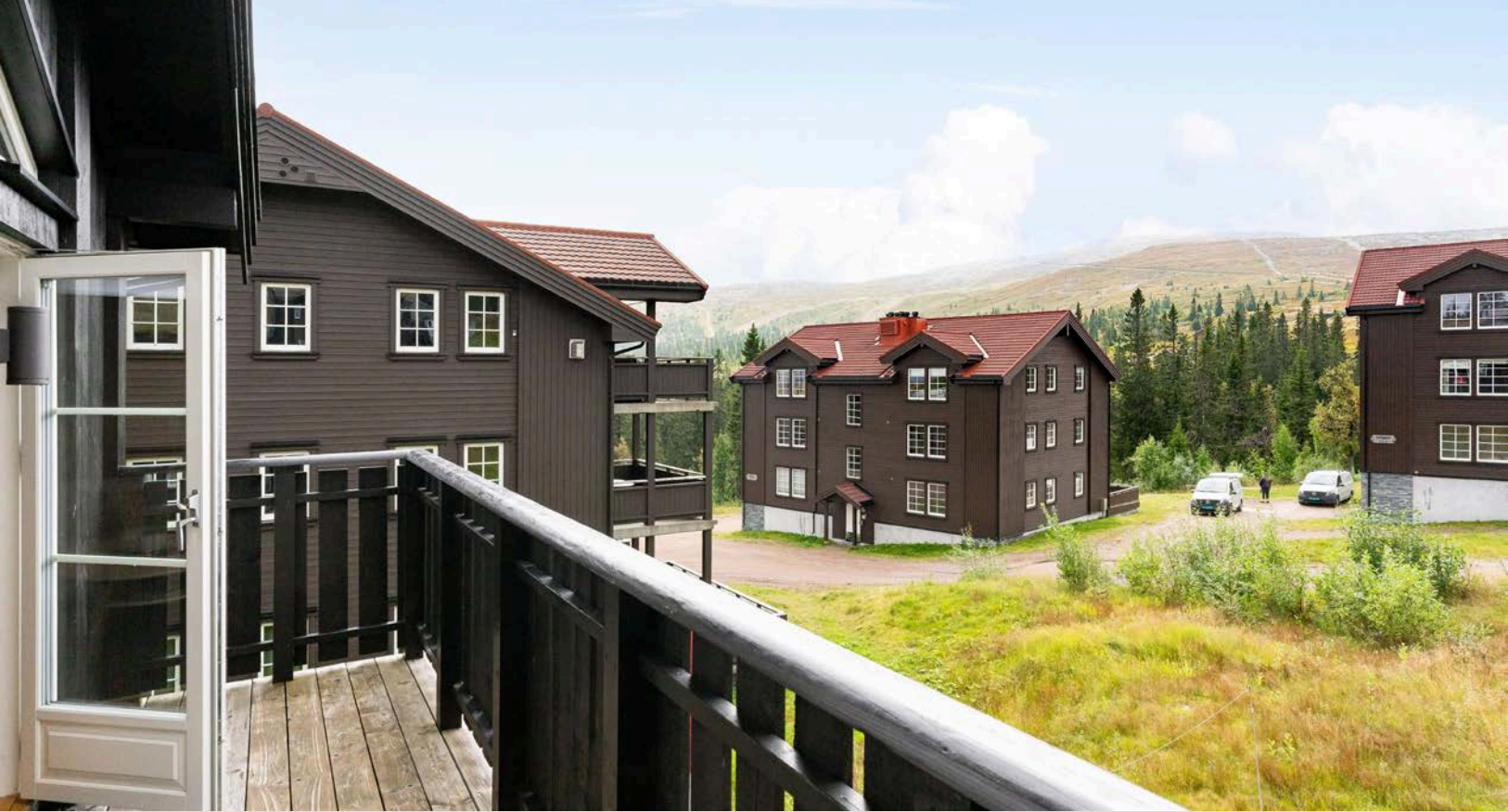
Fra stuen har du utgang til en solrik sydvendt balkong.
