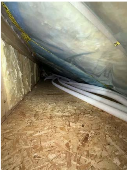
Viser raftekott med adkomst via luke.
