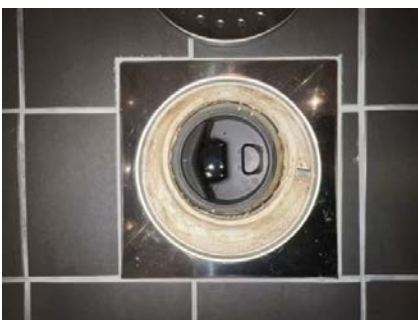
Viser sluk i dusjsjonen.
