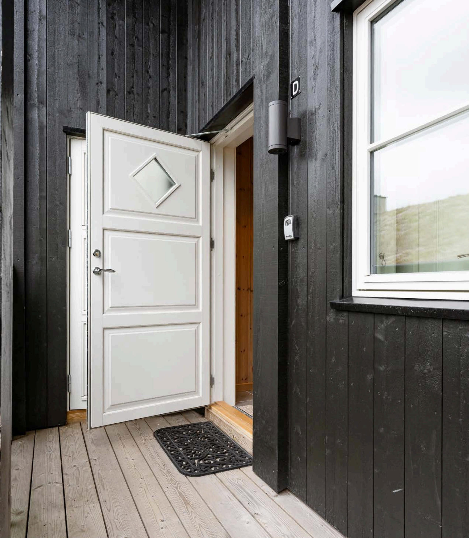
Overbygget inngangsparti i byggets 2. etasje.
