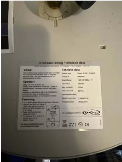
Viser teknisk data på bereder.
