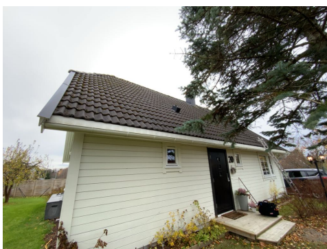
Besiktigelse av taktekke.
