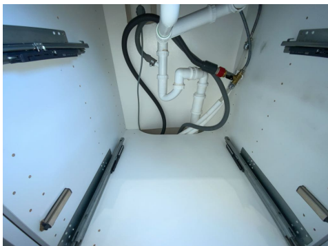
Besiktigelse av røropplegg.
