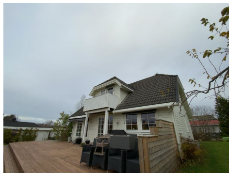
Besiktigelse av taktekke.
