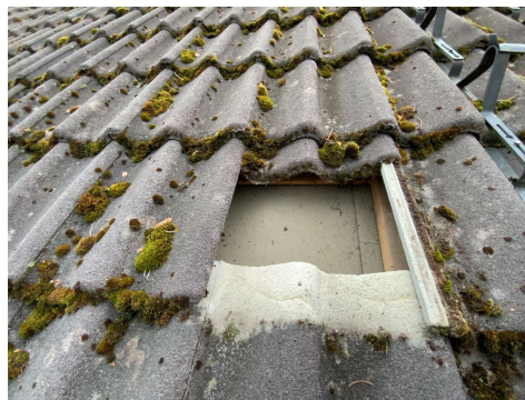
Kontroll av undertak.
