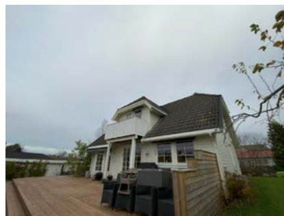
Besiktigelse av taktekke.
