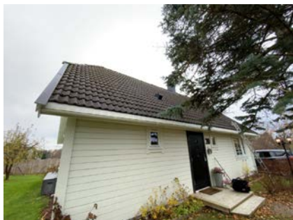
Besiktigelse av taktekke.
