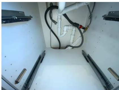
Besiktigelse av røropplegg.
