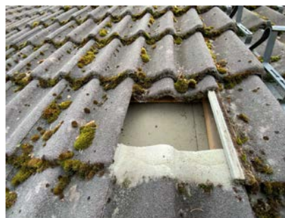
Kontroll av undertak.
