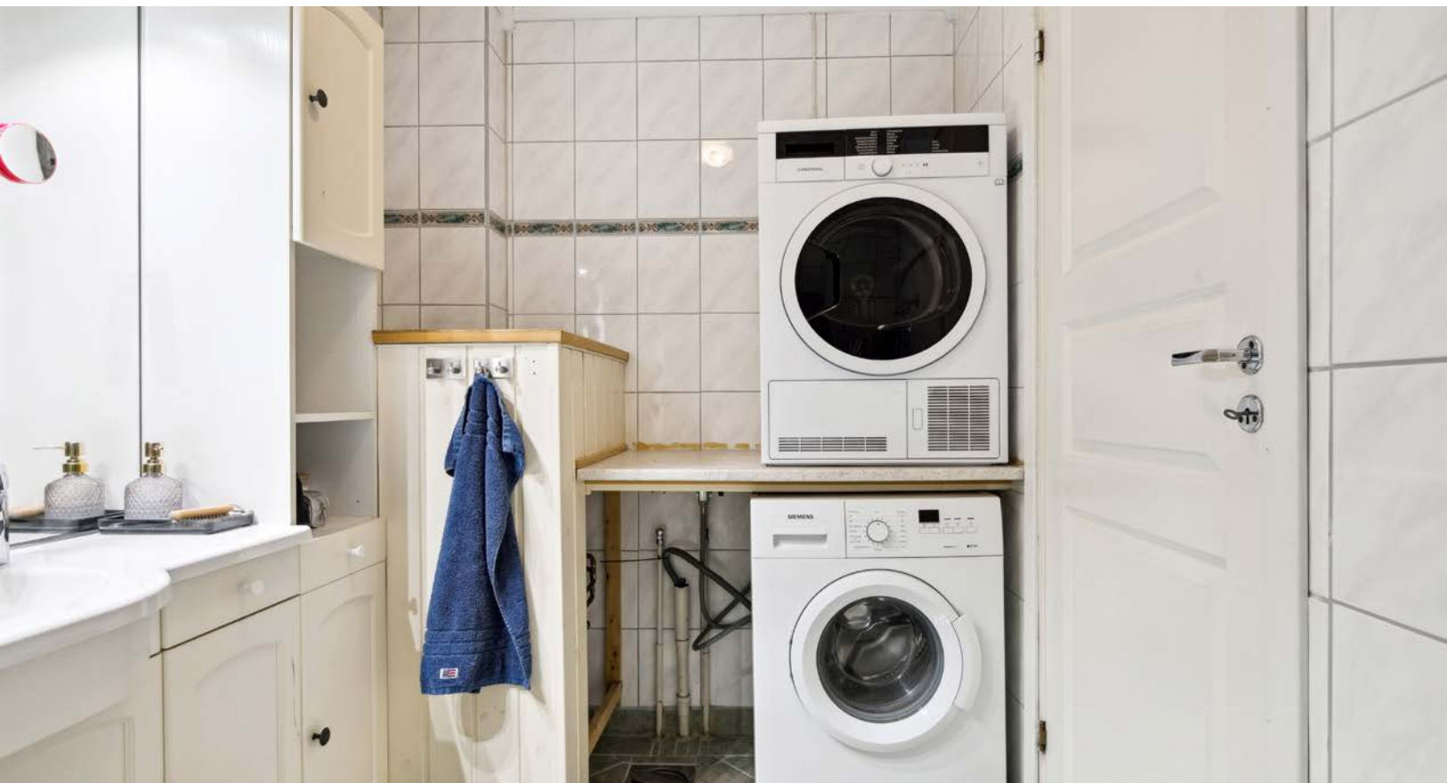
Badet inneholder baderomsinnredning, dusjkabinett, opplegg for vaskemaskin og 200 l varmtvannsbereder.
