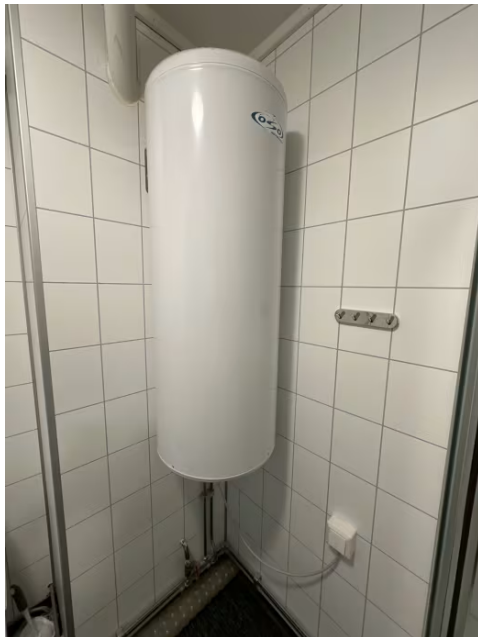
Viser vegghengt bereder plassert på badet.
