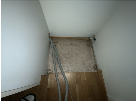
Kontroll bak oppvaskmaskin. Ingen tegn til fuktskader på befaringdagen.
