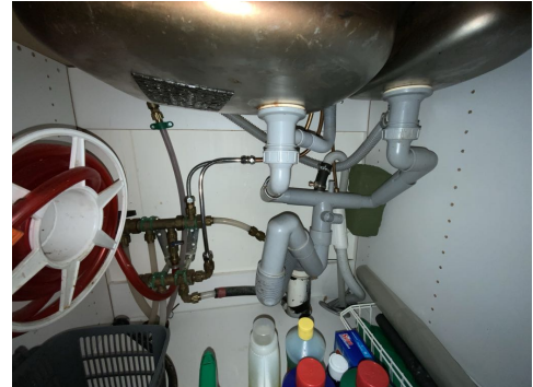
Besiktigelse av røropplegg.
