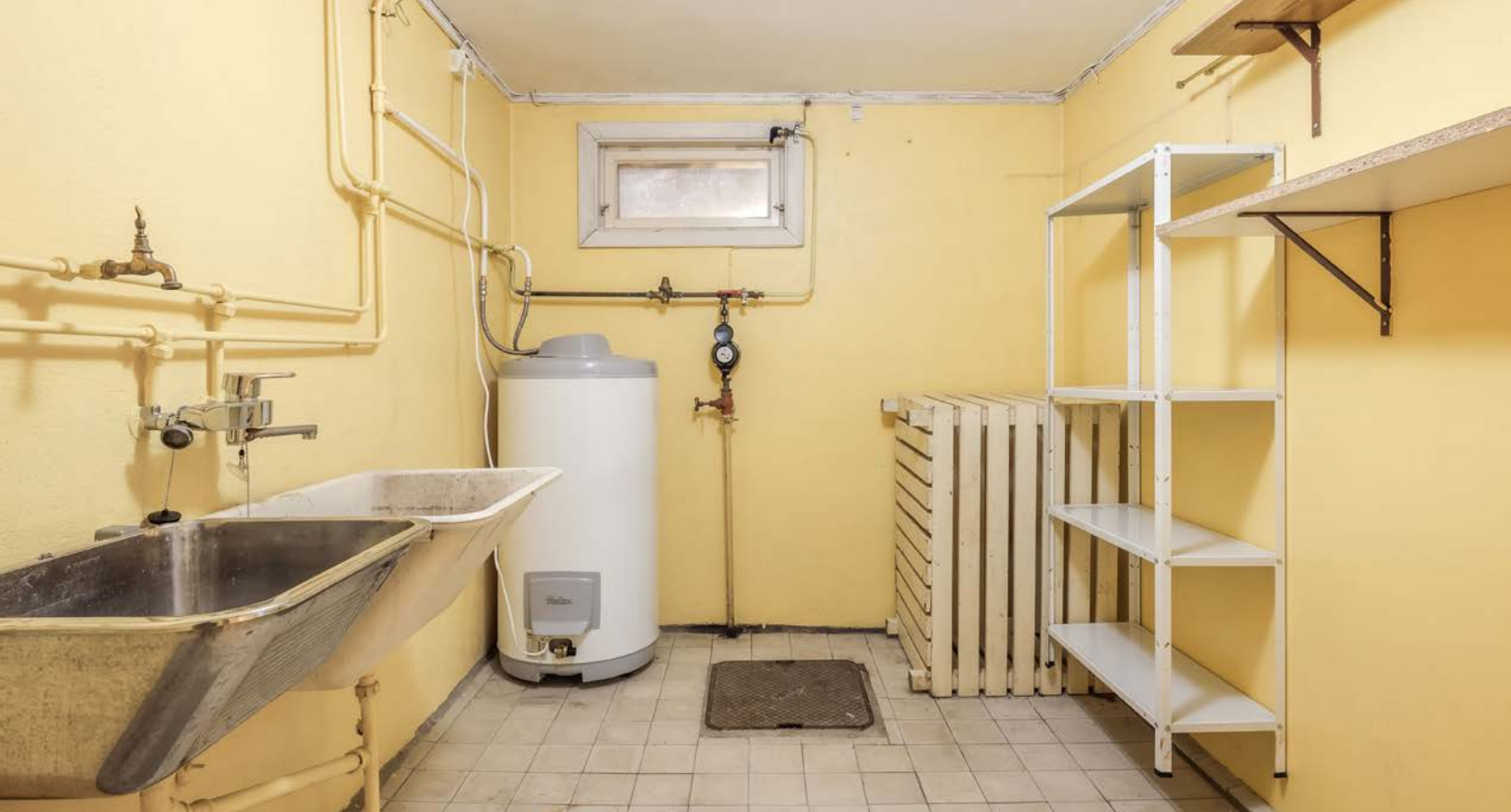
Enkelt vaskerom i underetasjen med flislagt gulv og utslagsvask.
