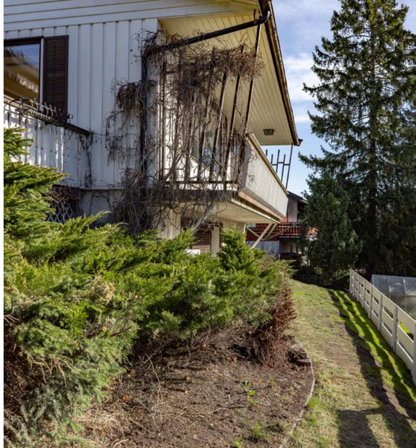
På fremsiden av boligen er det egen inngang til del i underetasjen.
