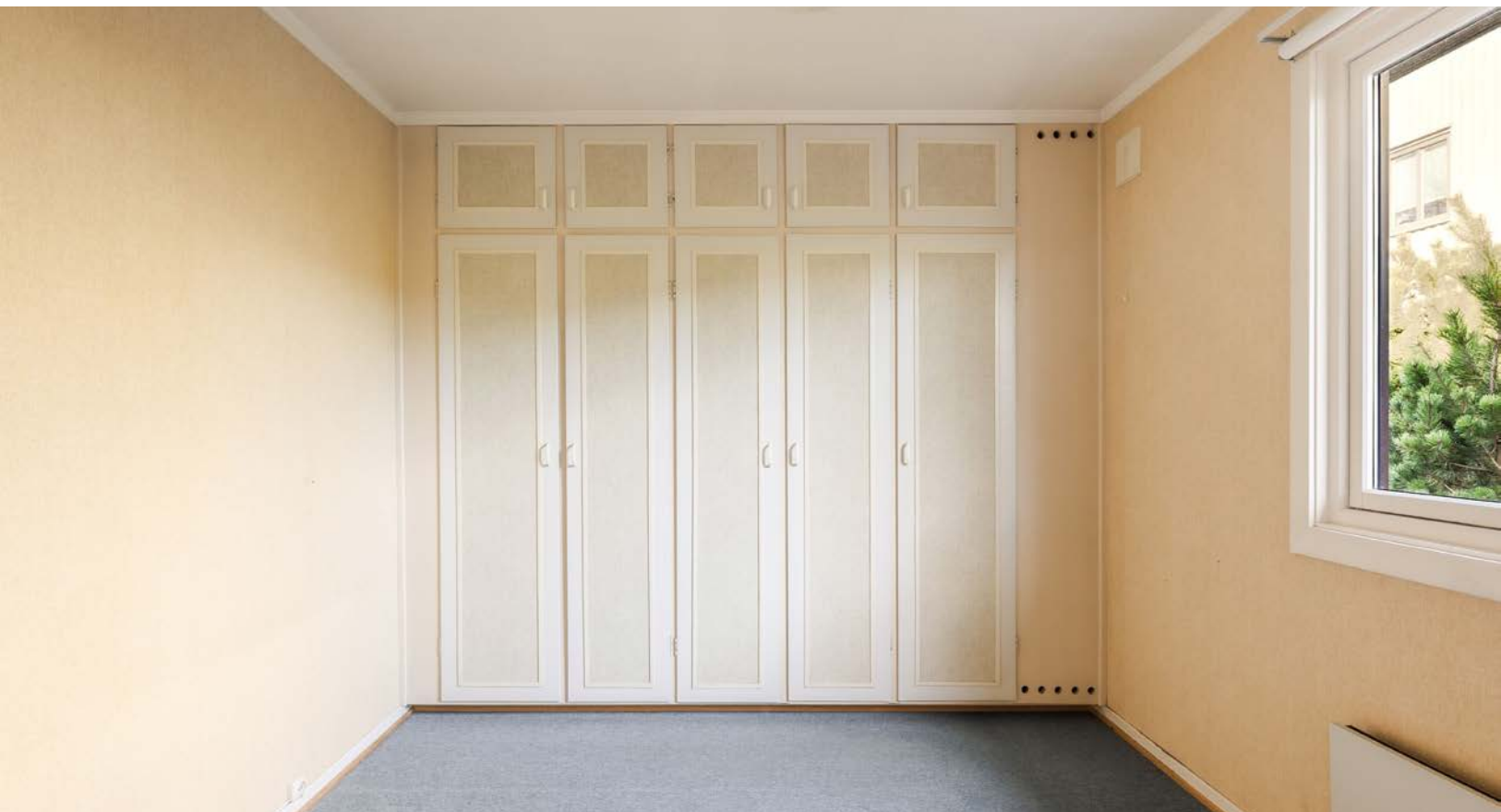
Dette er det største rommet med innebygde garderobeskap og plass til seng og andre ønskelig møbler.
