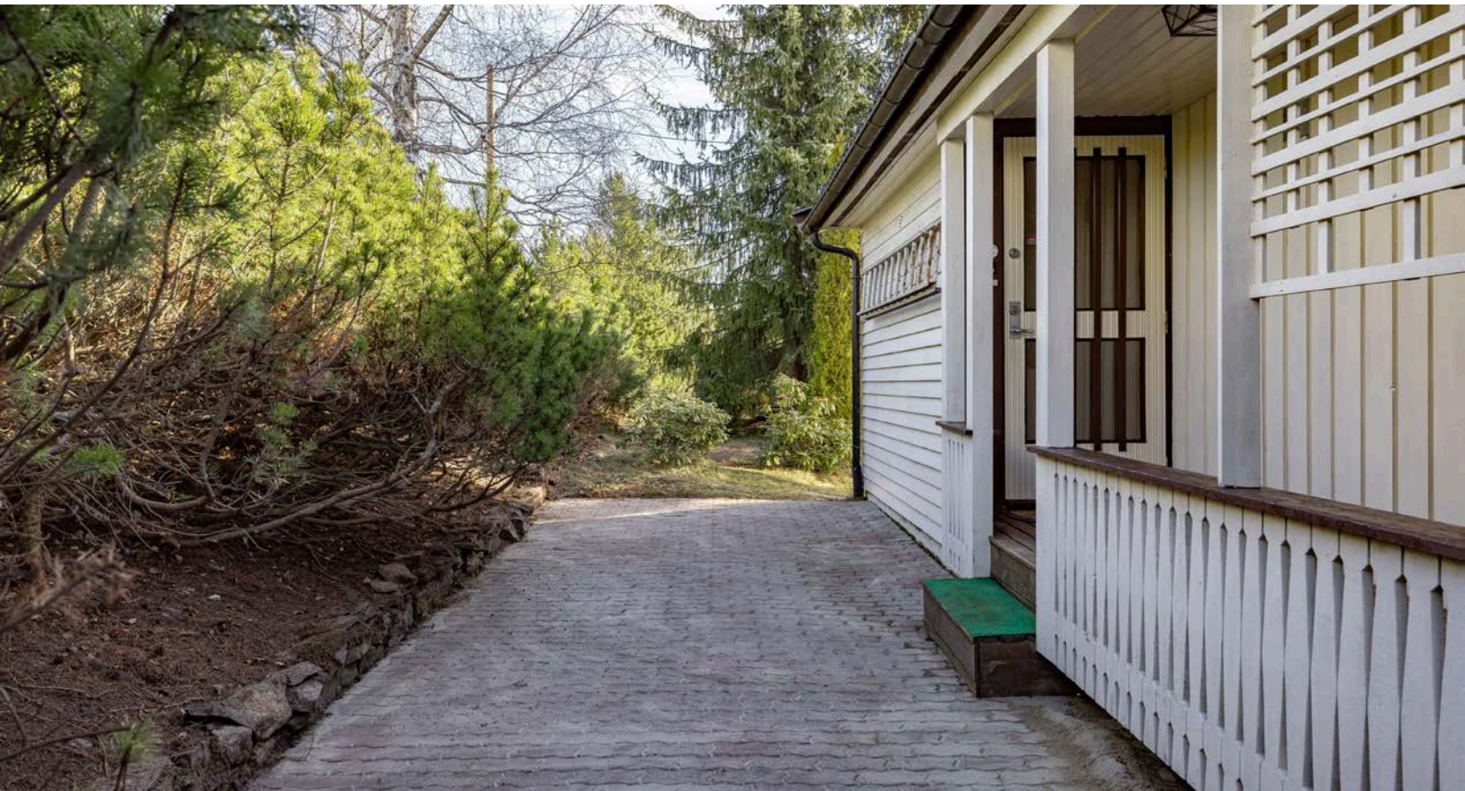
Inngangsparti på baksiden av boligen med belegningsstein.
