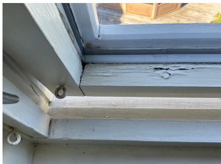
Enkelte eldre vinduer.
