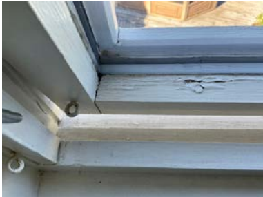
Enkelte eldre vinduer.
