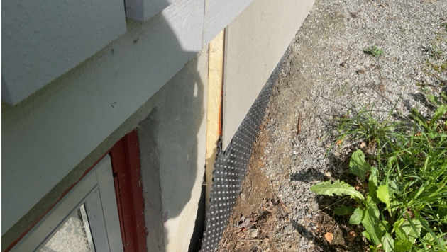
Synlig utvendig isolering på oversiden av bygningen
