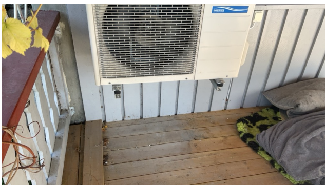
Utdel av varmepumpe mot yttervegg
