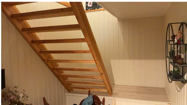
Manglende rekkverk
