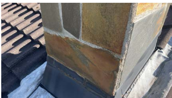
Bom (hullrom) i forblending på pipe over tak
