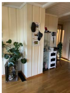
Fra 1.etasje er alle sidene på pipe innkledd
