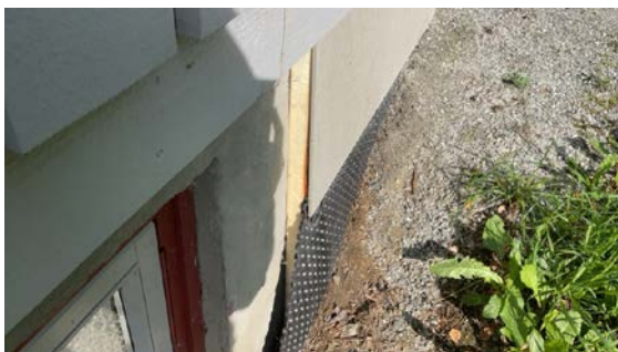
Synlig utvendig isolering på oversiden av bygningen
