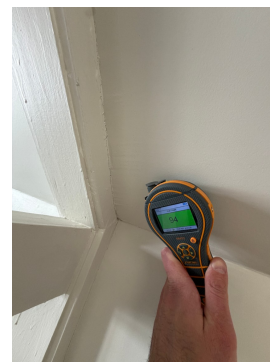
Overflate måling i skråtak, 2 etasje.
