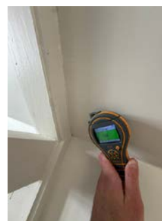
Overflate måling i skråtak, 2 etasje.
